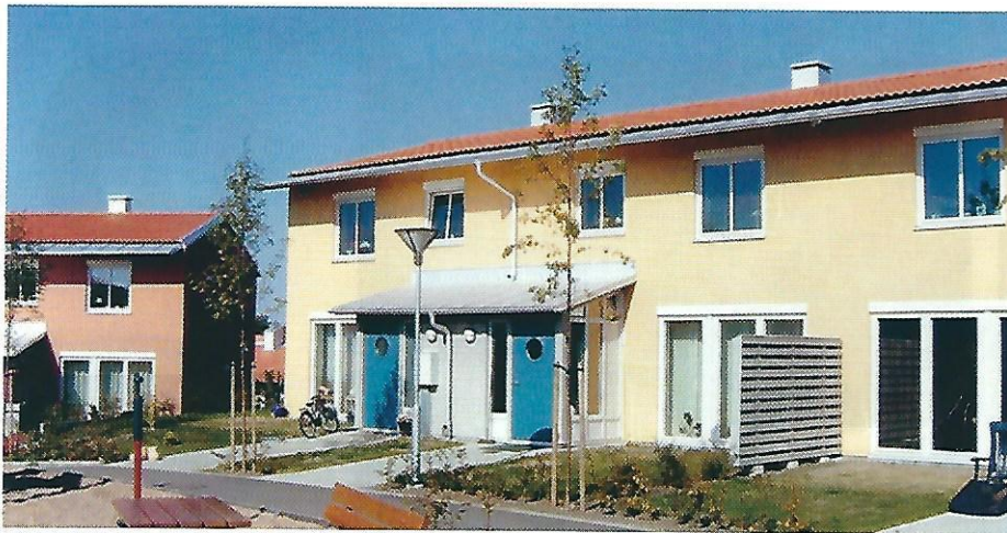
Figur 4. Passivhusen i Glumslöv. Solavskärmning den 23 september 2005 kl 13.15. Glasytor i bottenvåningen är helt oskärmda. Foto: Torbjörn Klittervall
