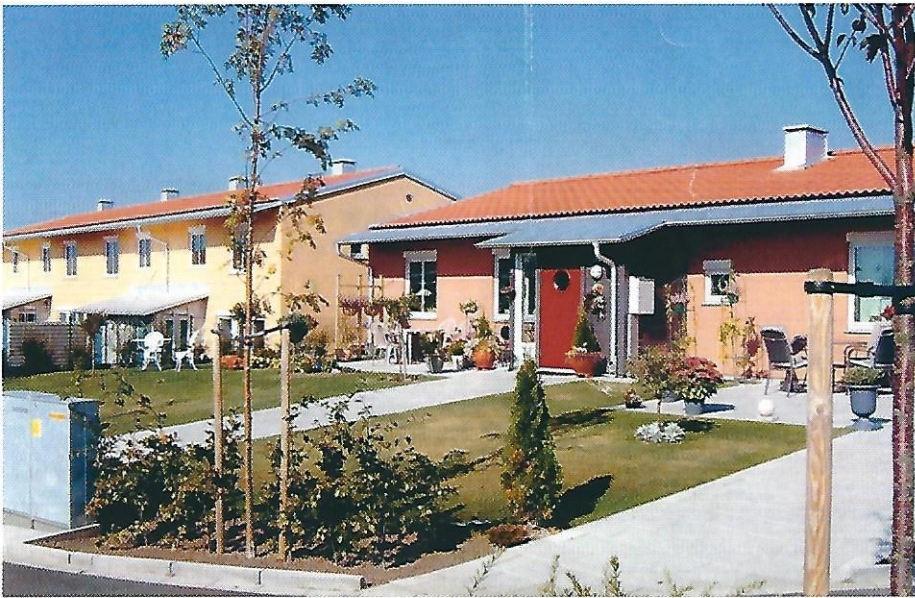
Figur 2. Passivhusen i Glumslöv har luftvärme med frånlufts- och tilluftsventilation, ventilationsvärmväxlare och elbatteri. Solavskärmning den 23 september 2005 kl 13.15. Foto:
