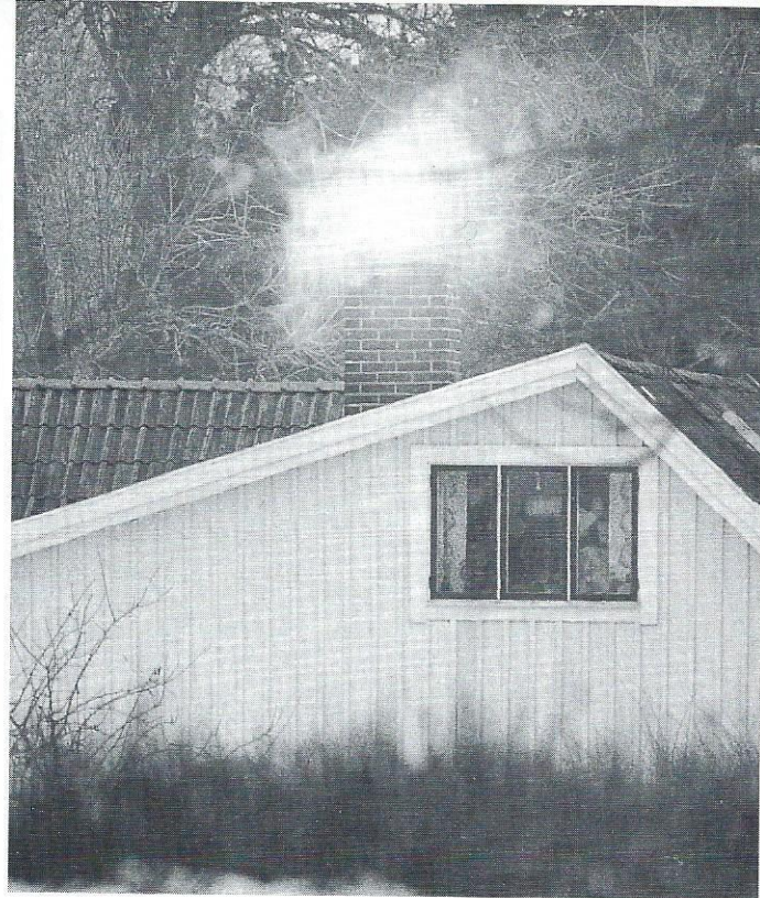
Rök från bl a vedeldning förs lätt in i tilluftskanalerna i hus med luftvärme, menar artikelförfattaren.
